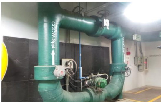
รูปที่ ค-3 การหล่อเย็นระบบหอหล่อเย็นแบบปิด (Closed Cycle Cooling Water System) ด้วย Absorber เพื่อลดระดับเสียง
