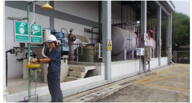
รูปที่ ค-12 การติดตั้งอุปกรณ์ชำระล้างฉุกเฉินบริเวณที่ต้องทำงานสัมผัสกับสารเคมี
