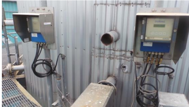
รูปที่ ค-1 ระบบการติดตามตรวจสอบการระบายมลสารต่อเนื่อง (Continuous Emission Monitoring System; CEMS)
