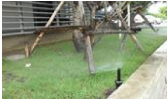
รูปที่ ค-9 การนำน้ำทิ้งที่ผ่านการบำบัดแล้วมาใช้รดน้ำต้นไม้ (ระบบสปริงเกอร์)
